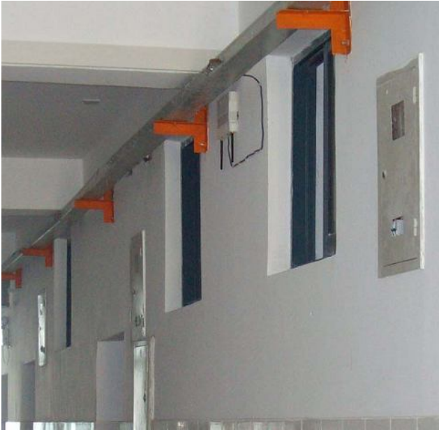
图 3-50 AP 壁挂式安装
